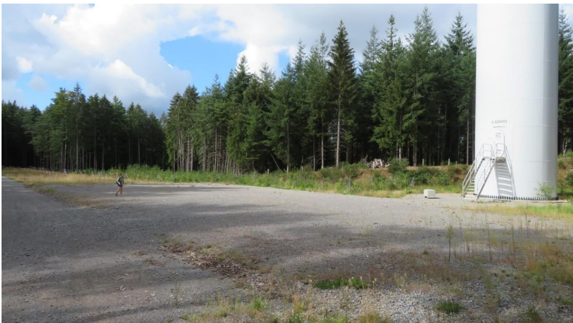
Bild 5: Gerodete Arbeitsfläche für Windkraftwerk (3,3 MW p 30 ) auf dem Gipfel des ursprünglich dicht bewaldeten Stillfüssels südlich Waldmichelbach
