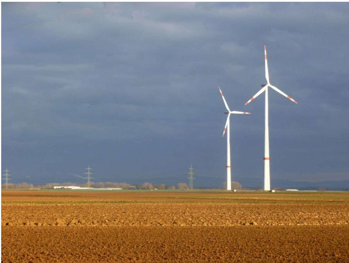
Bild 38: Windkraftwerke in der Rheinebene auf landwirtschaftlichen Flächen bei Haßloch/Pfalz
