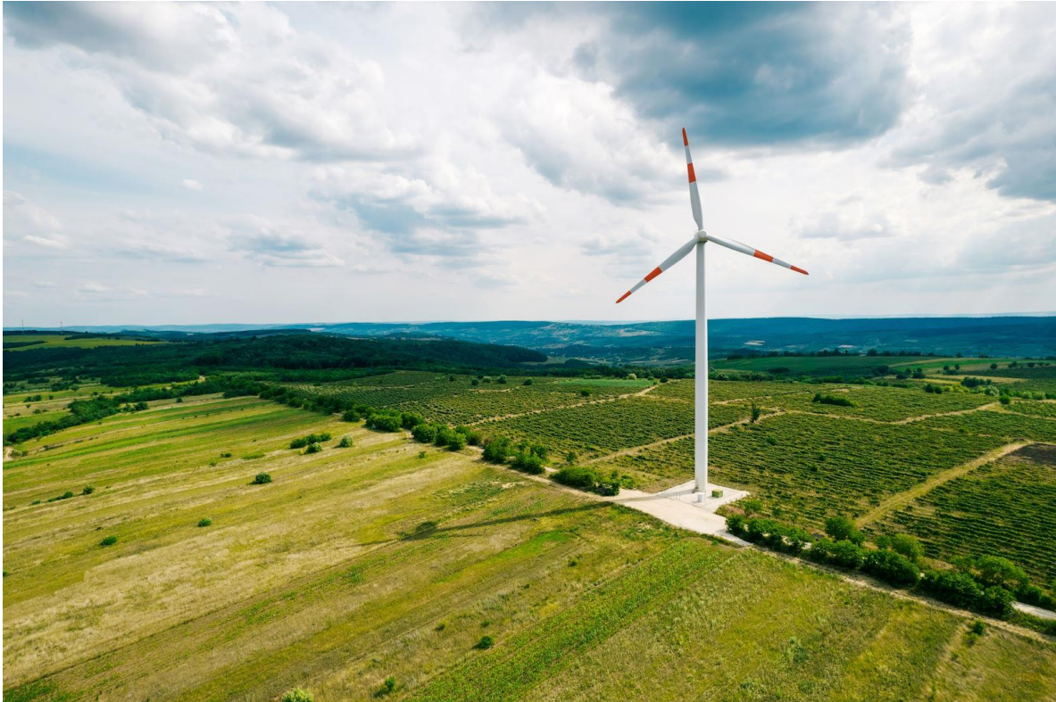
Bild 19: Windkraftwerk im Offenland in der Ebene
