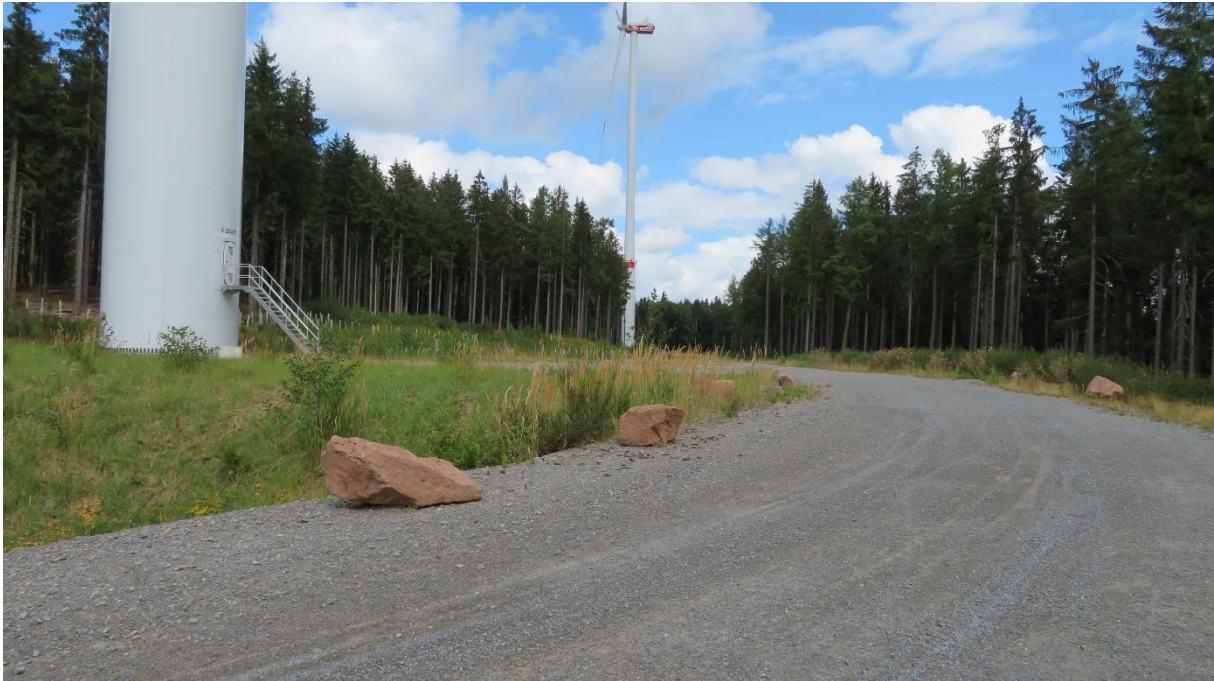
Bild 6: Wegebau und Geländemodellierung für Windkraftwerke auf dem Stillfüssel südlich Waldmichelbach
