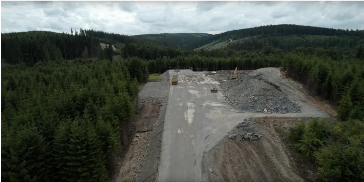
Bild 8: Geländeneivellierung für ein Windkraftwerk von 3,45 MW 31
