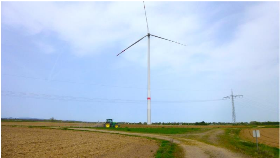
Bild 11: Windenergieanlagen in Schwegenheim bei Römerberg
