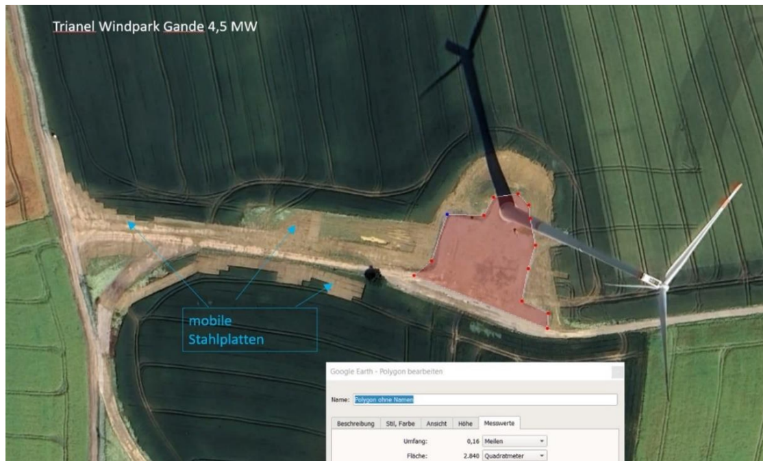
Bild 14: Bau einer 4,5 MW-Anlage im Offenland, dauerhafter Flächenverbrauch 0,28 ha 24 (rötlich), andere Flächen während Bau mit Stahlplatten belegt = temporär
