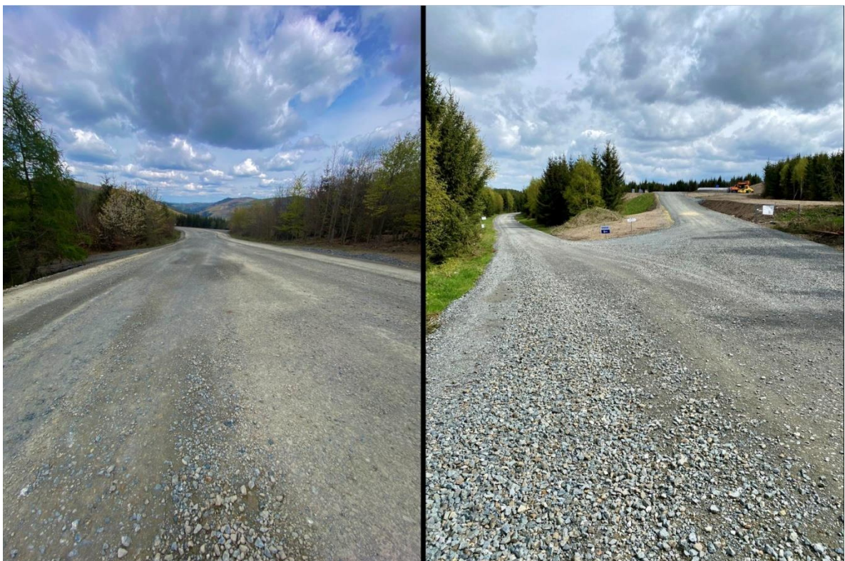
Bild 8: Wegebau für Windpark Mannstein 3,45 MW 19
