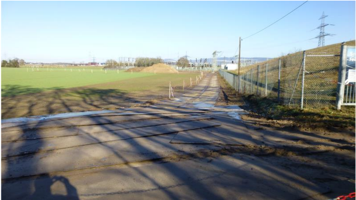
Bild 10: Mobile Stahlplatten zur temporären Ertüchtigung von Wegen
