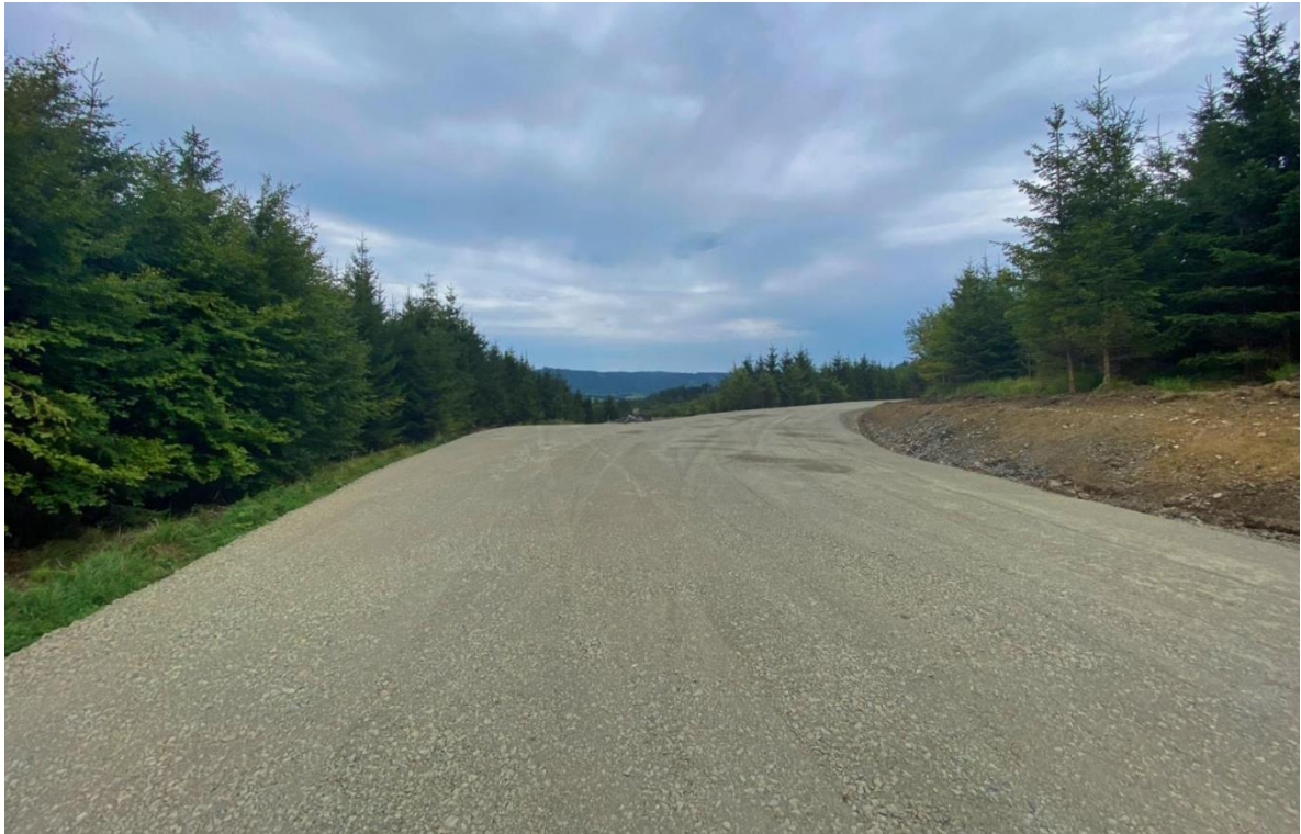
Bild 7: Wegebau für Windpark Mannstein 3,45 MW 19
